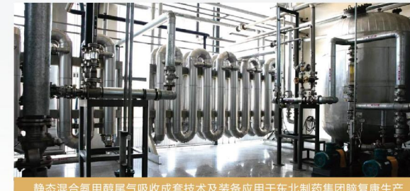
静态混合氨甲醇尾气吸收成套技术及装备应用于东北制药集团脑复康生产
