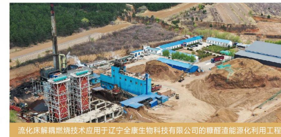
流化床解耦燃烧技术应用于辽宁全康生物科技有限公司的糠醛渣资源化利用工程
